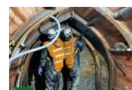
支保工組立状況
