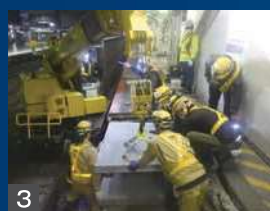
3 基礎設置 (軌道クレーン使用)
