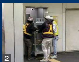
2 基礎運搬 (エレベーター使用)
