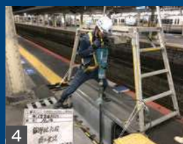
4 小径鋼管杭打設 (人力施工)
