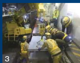
3 基礎設置 (軌道クレーン使用)
