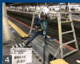
4 小径鋼管杭打設 (人力施工)
