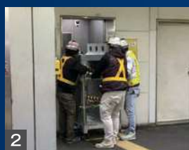
2 基礎運搬 (エレベーター使用)
