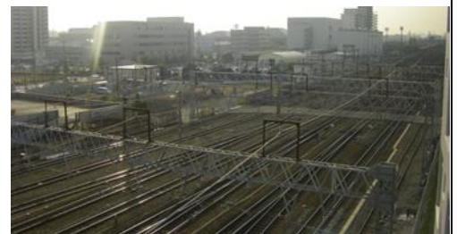
線路写真（施工前）
