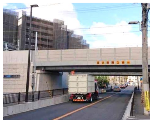
改築後の架道橋
