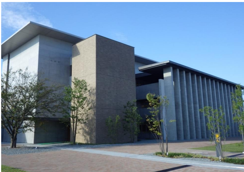
建物外観（北東面より）
