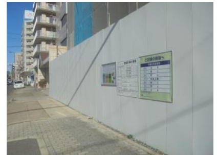
現場掲示状況
