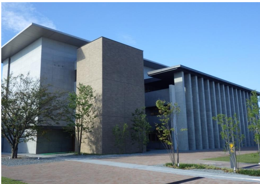
建物外観（北東面より）
