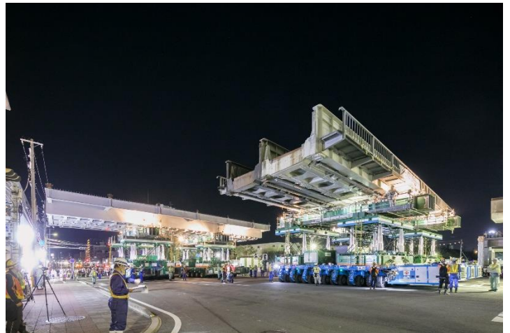
多軸台車による撤去桁および新桁の運搬
