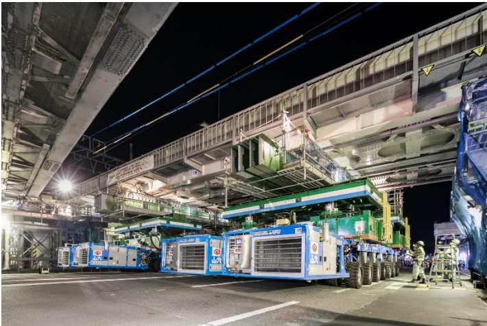
多軸台車による桁撤去
