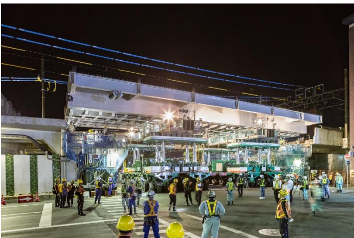
多軸台車による桁架設
