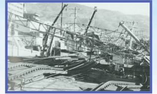
1995 六甲道駅付近被災状況(兵庫県)
