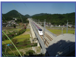
2002 九州新幹線 軌道新設(熊本県)
