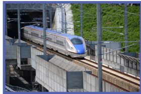
2015 北陸新幹線軌道新設 (富山県)
