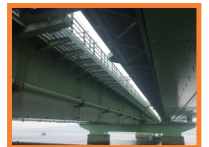
2019 関西空港連絡橋 災害復旧(大阪府)
